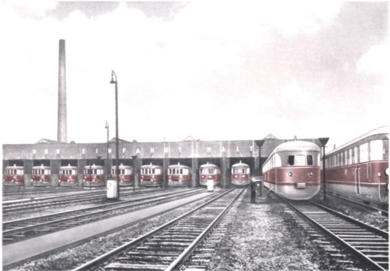
Deutschland : Bahnbetriebswerk für Diesellokomotiven
