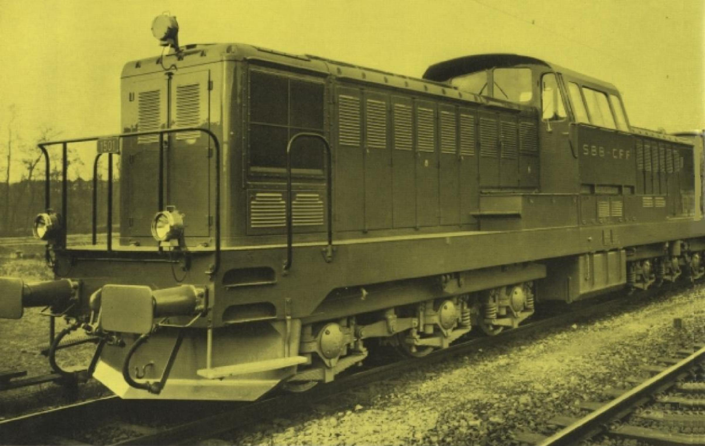
**1700 PS Diesel-elektrische Rangierlokomotive, Achsfolge CoCo, Serie Bm 6/6
